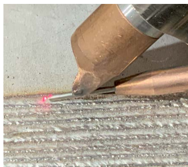
Bild 7. Handgeführtes Laserstrahlschweißen beim lokalen flächigen Beschichten (links) und Reparatur von Schneckenstegen (rechts)
